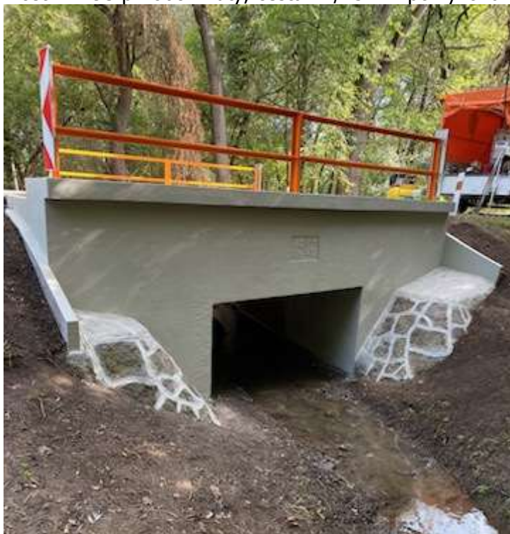
Most M1493 pri obci Bruty, cesta III/1521 - po vykonaní stavebnej údržby
