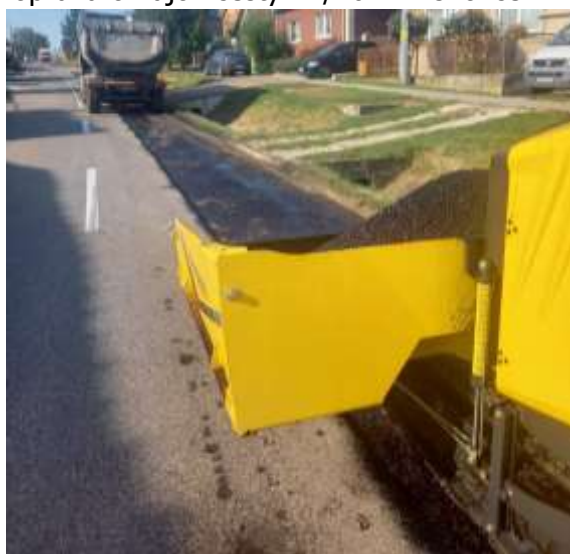
oprava okrajov cesty III/1674 Rišňovce
