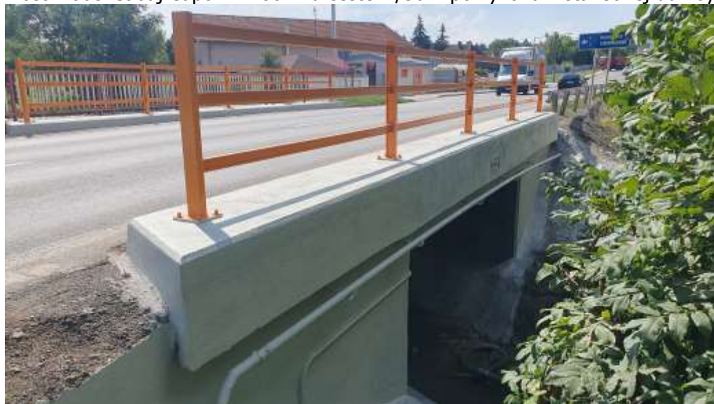
Most v obci Cabaj Čápor M 2801 na ceste II/562- po vykonaní stavebnej údržby
